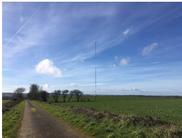
Figure 2 : Mât de mesure de vent
